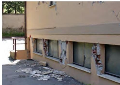
Figure 2: Poteaux courts créés par une ouverture dans la maçonnerie.
